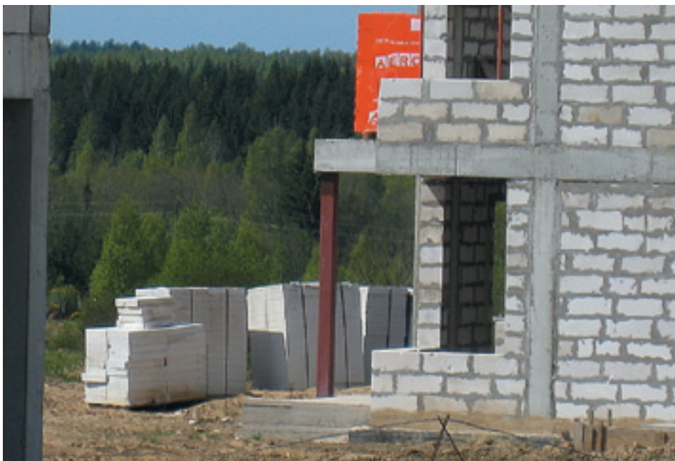
Малозэтажное строительство из газобетона не требует применения сложной техники. Н+Н
