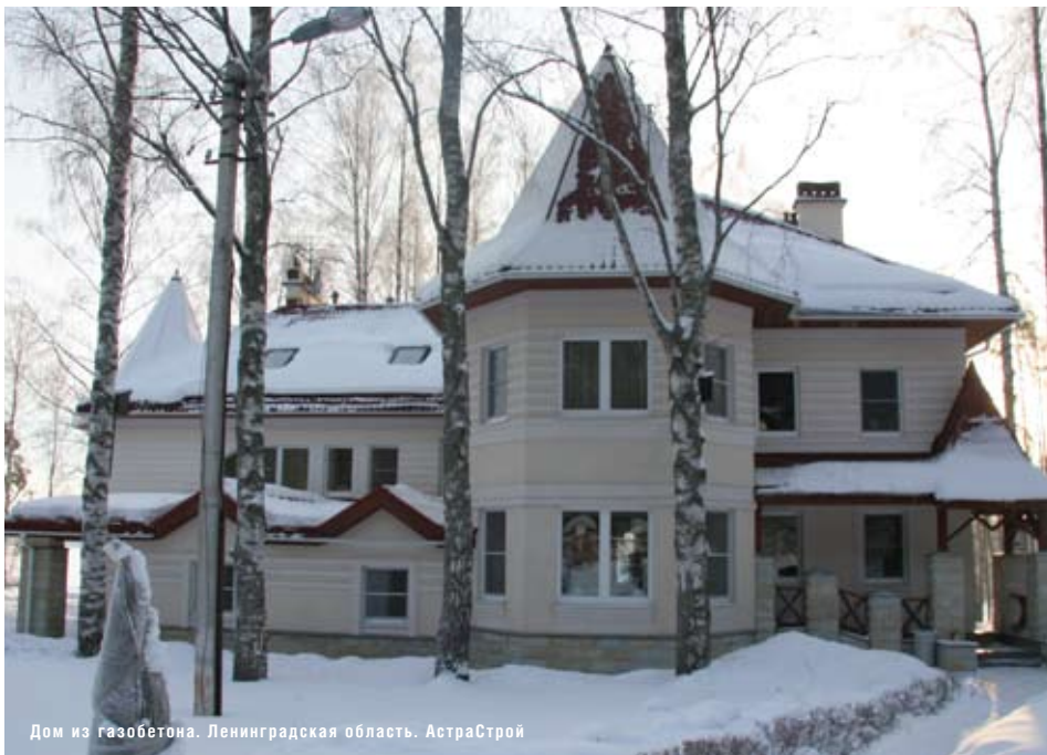
Дом из газобетона. Фасад выполнен облицовочным кирпичом. Ленинградская область. АстраСтрой
