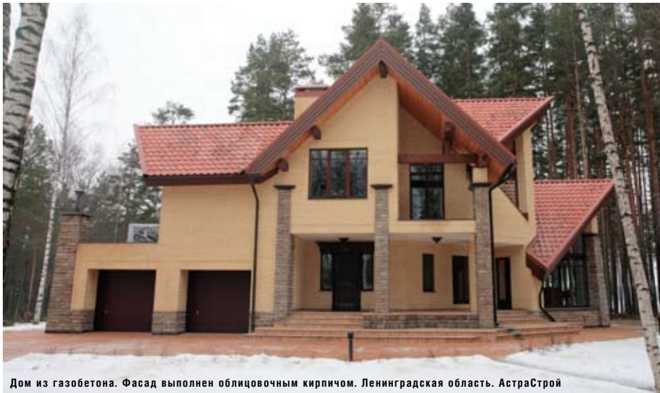
Дом из газобетона. Фасад выполнен облицовочным кирпичом. Ленинградская область. АстраСтрой
