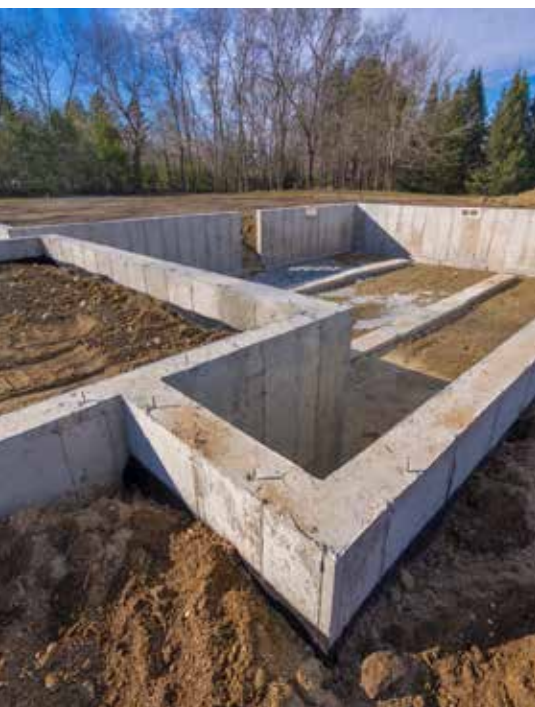
Ленточный фундамент не только самый надежный и обладающий наибольшей несущей способностью, но и самый дорогой
